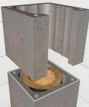
Устанавливаем подготовленный блок. Проверяем уровнем.
