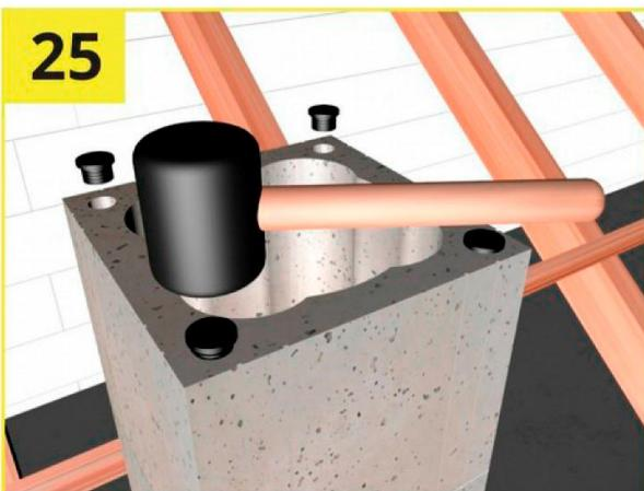
Чтобы произвести дополнительное армирование дымохода, следует на необходимой высоте (см. выше п.№14 «Информация по установке») установить заглушки для шпилек (арматуры). Далее монтируются детали дымохода, в отверстия по углам блока вставляются метровые куски шпильки либо арматуры ф8/ф10 и проливаются раствором М150-М300 на всю глубину.
