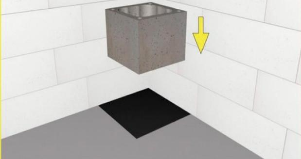
На фундаменте, в соответствии с проектной документацией, укладываем слой изоляции, устанавливаем первый блок дымохода, выравниваем при помощью уровня, заливаем бетоном М150. Проверяем уровнем.
