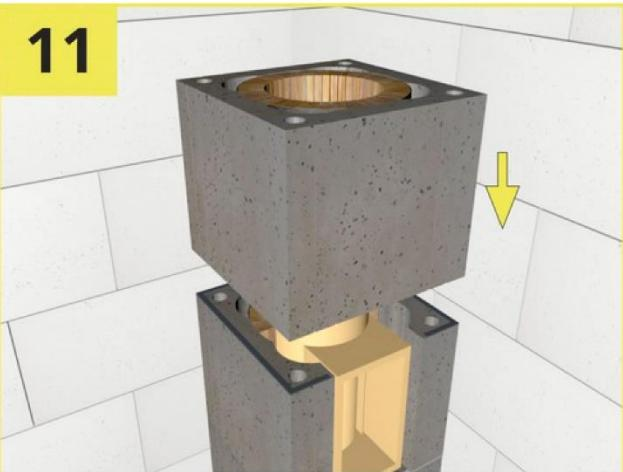
Наносим раствор M150 на смонтированный блок, монтируем следующий блок. Проверяем уровнем.
