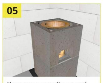
Монтируем каменную вату. Стыки каменной ваты должны быть на середине стенки блока, лишнюю каменную вату обрезаем по верхнему краю блока.
