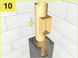
Монтируем тройник ревизии на конденсатосборник, удаляем излишки смеси влажной губкой. Тройник ревизии должен совпасть с пазами на конденсатосборнике в соответсвии с диаметром тройника ревизии.
